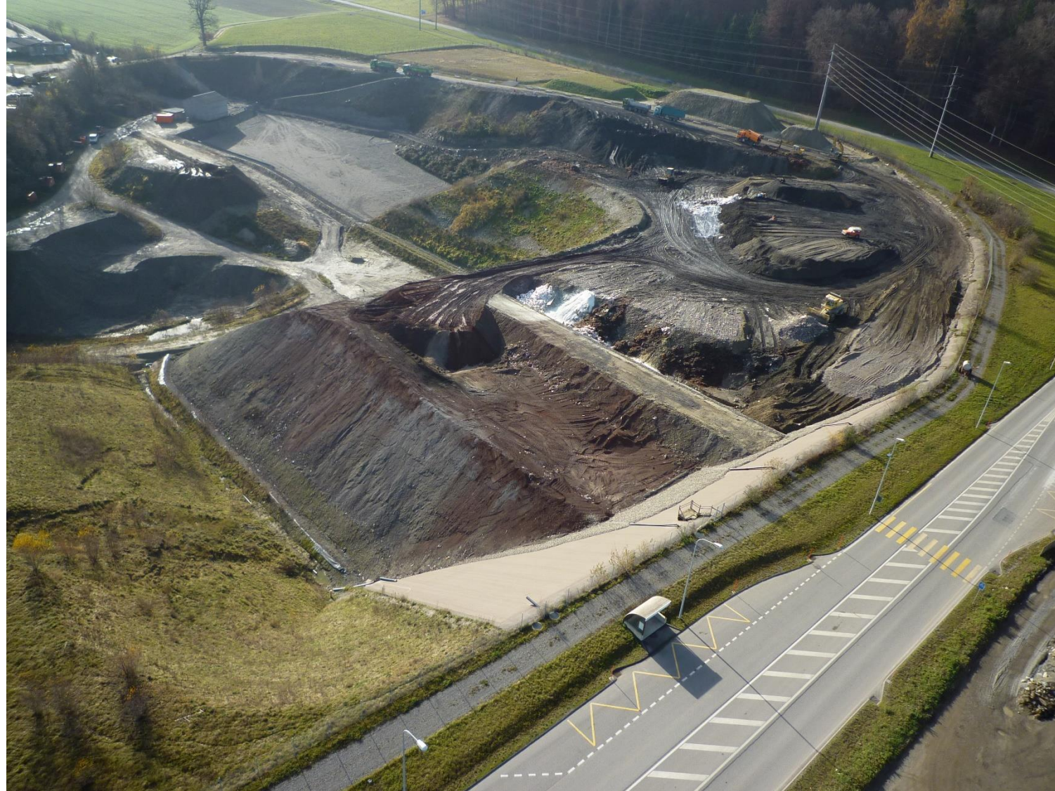
Décharge de Châtillon types D-E Fribourg, photo J.-C. Balmer
